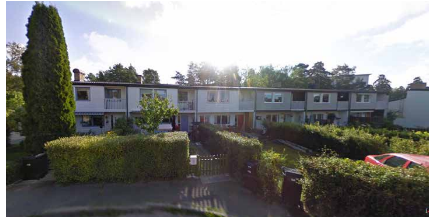
Radhus Längs Ardennergatan i Hässelby Gård. På Ardennergatan 7 byggdes den 8000:e småstugan i Stockholm.
